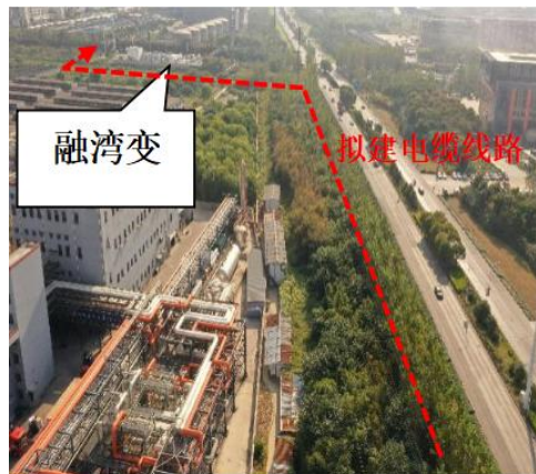
拟建电缆线路沿临海大道路敷设
